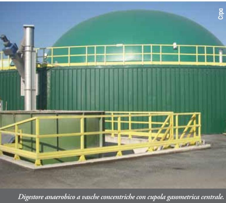
*Digestore anaerobico a vasche concentriche con cupola gascometrica centrale.*
