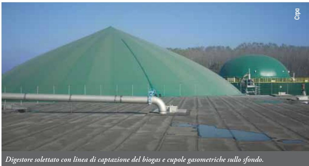
*Digestore solettato con linea di captazione del biogas e cupole gascometriche sullo sfondo.*
