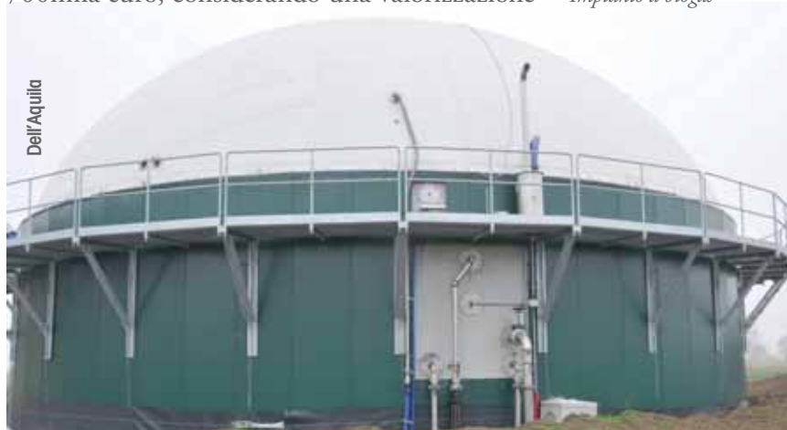
Impianto a biogas
