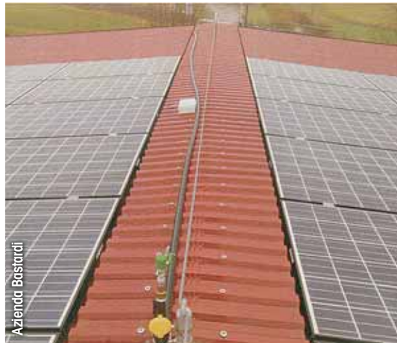
Impianto fotovoltaico su un capannone dell'azienda agricola Bastardi di Reggio Emilia. Il bilancio energetico è uno dei parametri presi in considerazione per valutare impatto ambientale e performance economiche di un'azienda zootecnica
