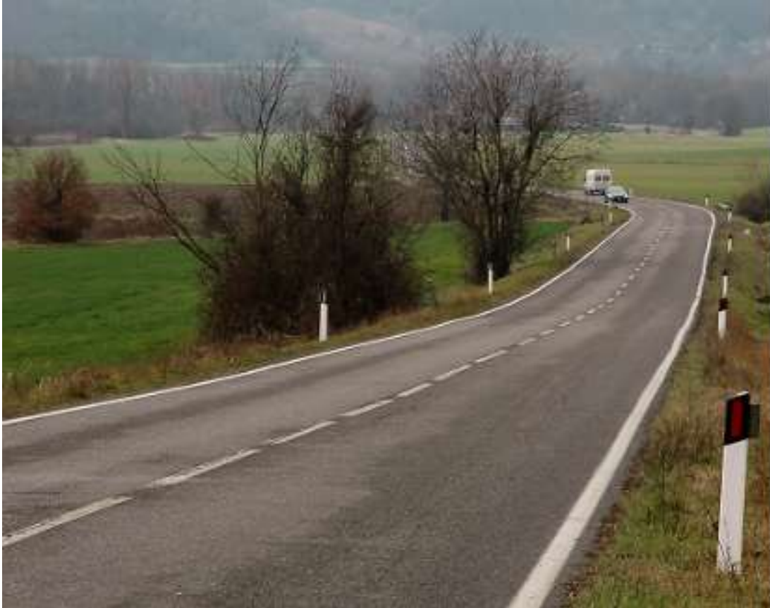
1.7.2-F6 Dissuasori elettronici alternati a catarifrangenti nel tratto di Castelnuovo Fogliani (Piacenza).
