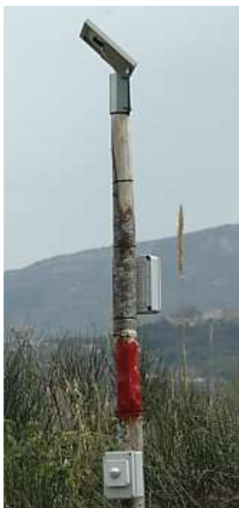
1.7.2-F2 Componenti utilizzati per l'impianto di Ponte Messa (RN): a sinistra sensore di movimento; a destra cartello verticale con lampeggianti. Entrambi i dispositivi sono alimentati da pannello solare.
