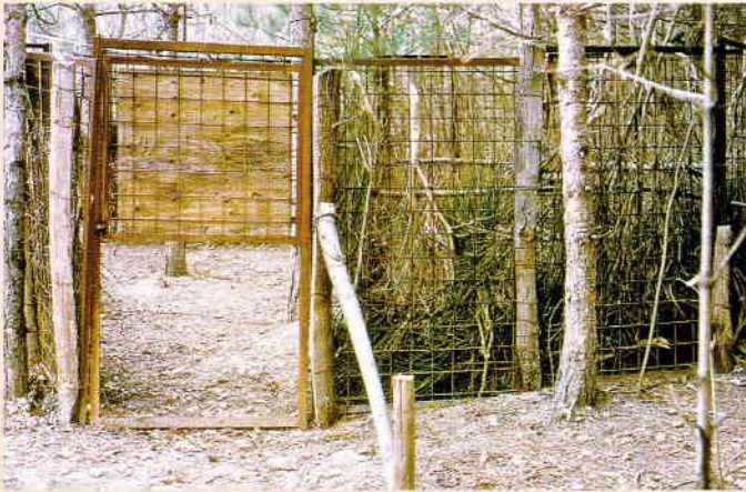
Figura 42 - Ancoraggio dei pannelli agli alberi circostanti.
