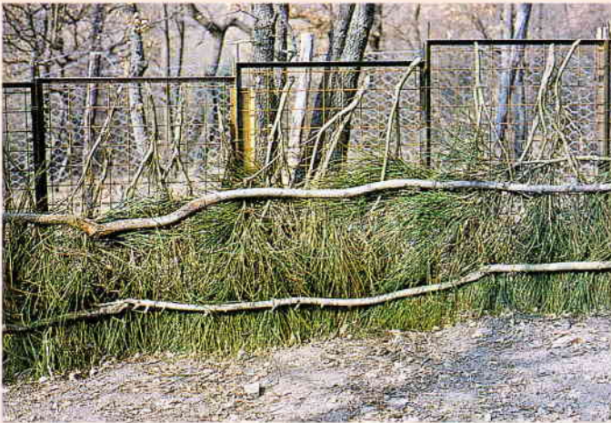
Figura 43 - Rivestimento del chiusino con fascine di ginestra.
