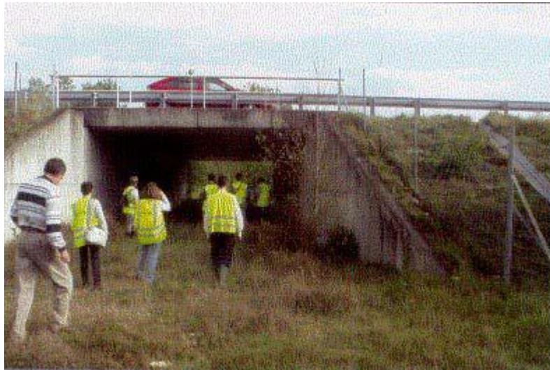
(Un sottopasso in Slovenia, detto Box Culvert; foto concessa da U.S Federal Highway Administrator)
