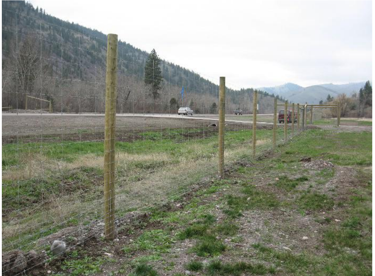
(Foto di M.Huijser: recinzione di 2.4 mt per grandi ungulati, con maglie più strette alla base, lungo la Highway 9,3 nella Flathead Riserva, Montana, U.S.A.)
