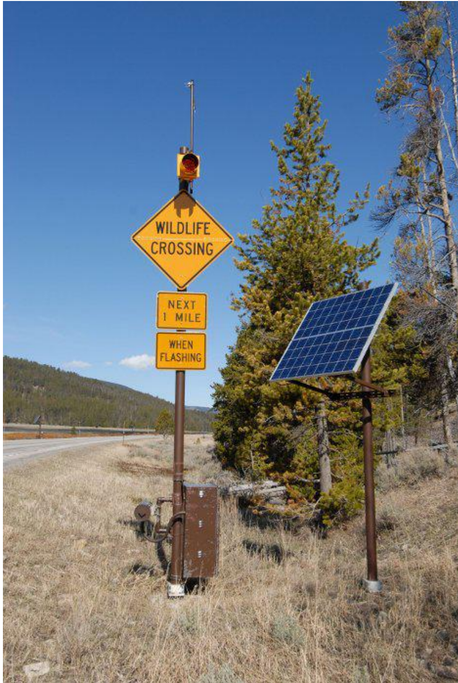
(Foto di Marcel Huijser: sistema di arresto degli animali lungo la Highway191 nel Parco Nazionale dello Yellowstone, Montana, U.S.A.)
