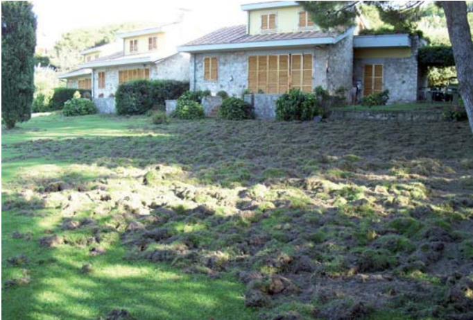
Figura 3.4 - Prato completamente distrutto dall'attività di scavo. (Foto F. Giannini).
