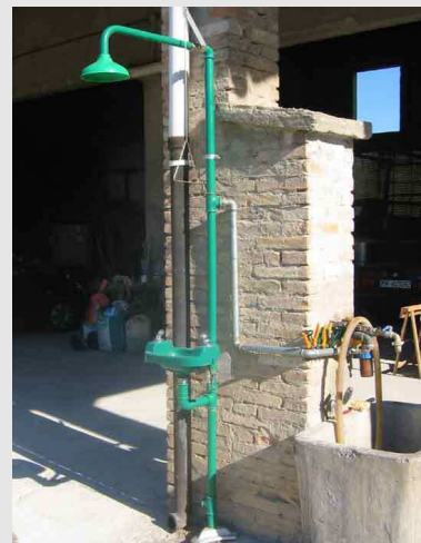
Doccia di emergenza in caso di esposizione a prodotti fitosanitari (Foto Cons. Fito. Parma)
