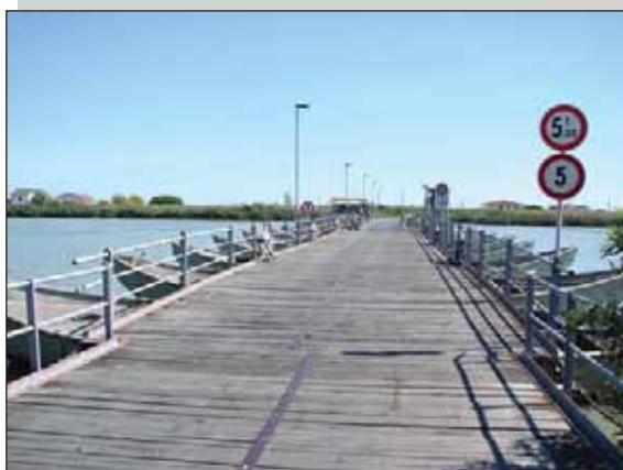
Il Ponte di barche di Gorino.
