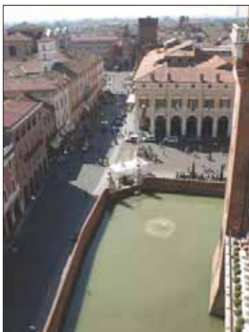
Vista del centro di Ferrara dall'alto.
