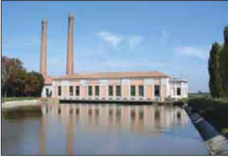
Impianto idrovoro sul Po di Volano.
