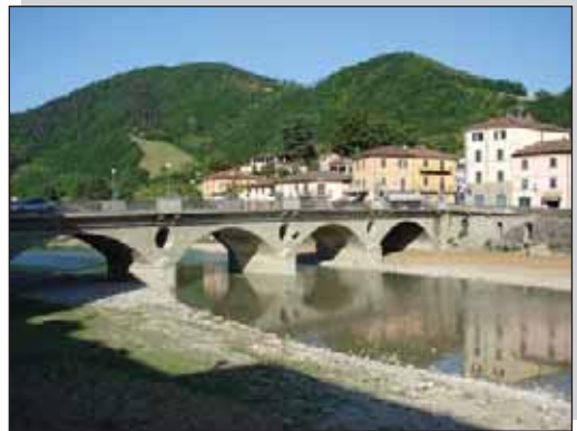
Il ponte sul Bidente a Santa Sofia.
