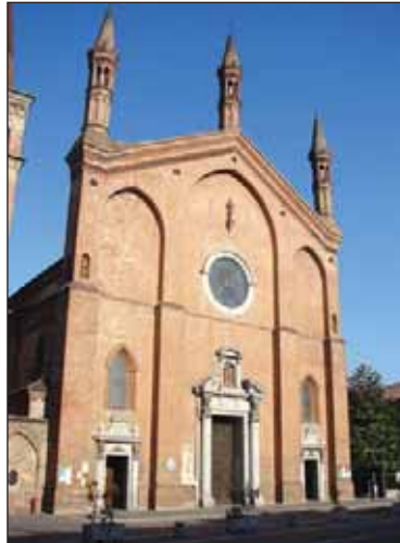
Facciata della Collegiata di Castel San Giovanni.
