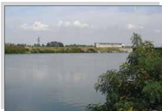
Il Cavo Napoleonico in prossimità della paratia sul fiume Po.
