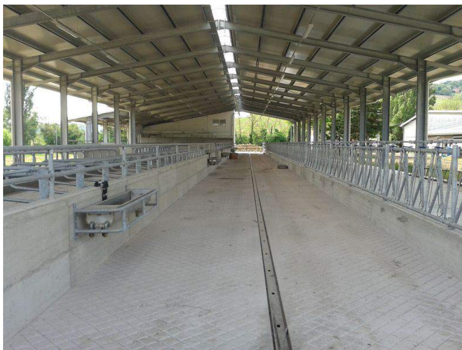
Figura 1.3 – Pavimento pieno di calcestruzzo nella corsia di alimentazione di una stalla a stabulazione libera per bovine da latte
