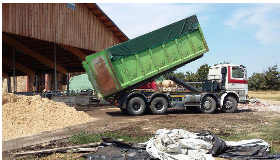
Figura 3.5 – Autocarro che scarica segatura presso l'azienda B
