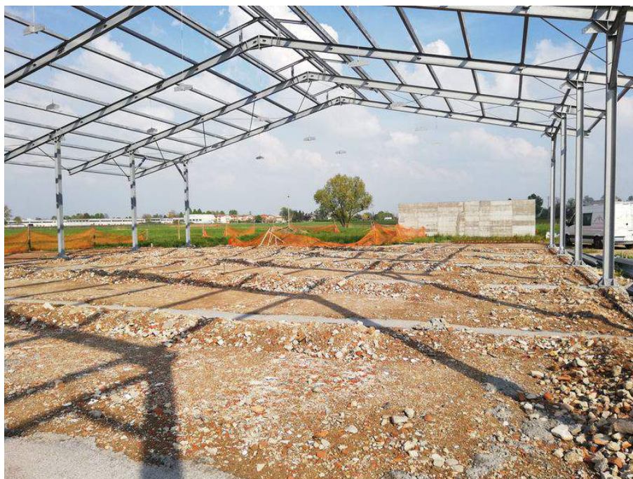
Figura 3.1 – La situazione della nuova stalla compost dell'azienda A nel momento dell'interruzione dei lavori di costruzione
