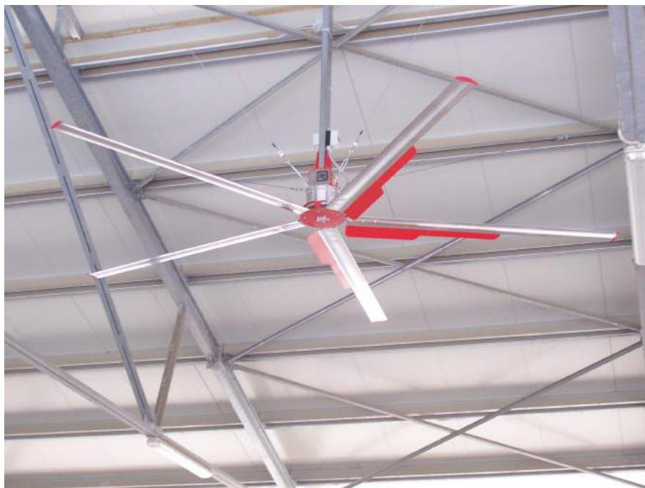
Figura 1.5 – Ventilatore assiale a pale di grande diametro del tipo “elicottero” a cascata d'aria, per il raffrescamento delle aree di stabulazione
