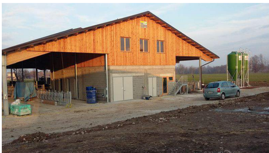
Figura 2.6 – Il corpo mungitura e servizi alla testata Sud della stalla dell'azienda B
