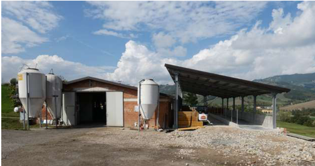
Vista esterna dell'ampliamento della stalla di AP2 con nuova zona a stabulazione libera a cuccette
