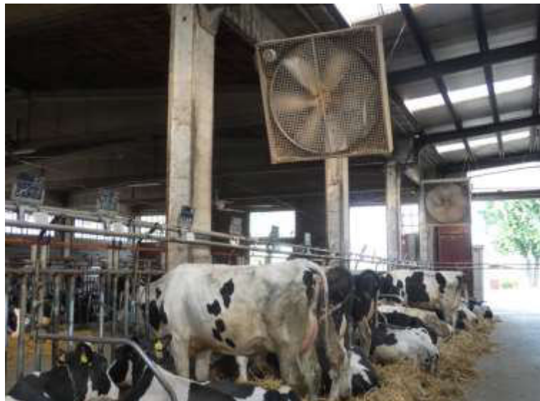
Ventilatori elicoidali in serie sopra una fila di poste (tunnel di vento) nella stalla di AP4
