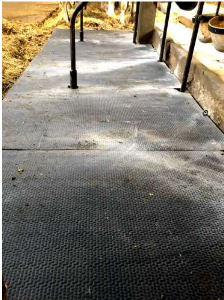
Nuovo tappetino Lenta (Kraiburg) installato nelle 44 poste destinate alle vacche in lattazione dell'Azienda Pilota AP1
