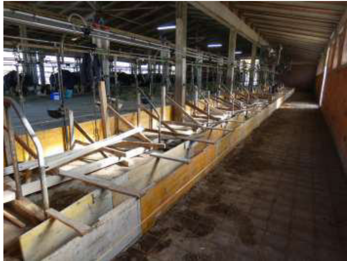
Rifacimento del pavimento della posta e della corsia di servizio della stalla fissa in AP2
