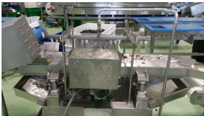
Fig. 1: Vista impianto di lavaggio
