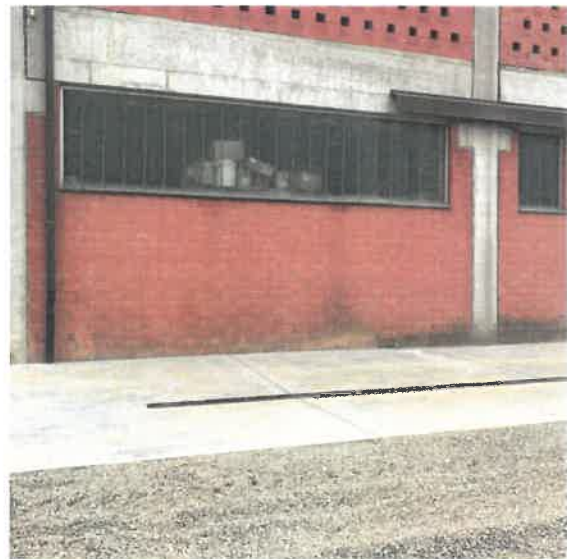
Figura 3.2.5. Pianta Piazzola e visione frontale area preparazione miscela con griglia recupero acque.
