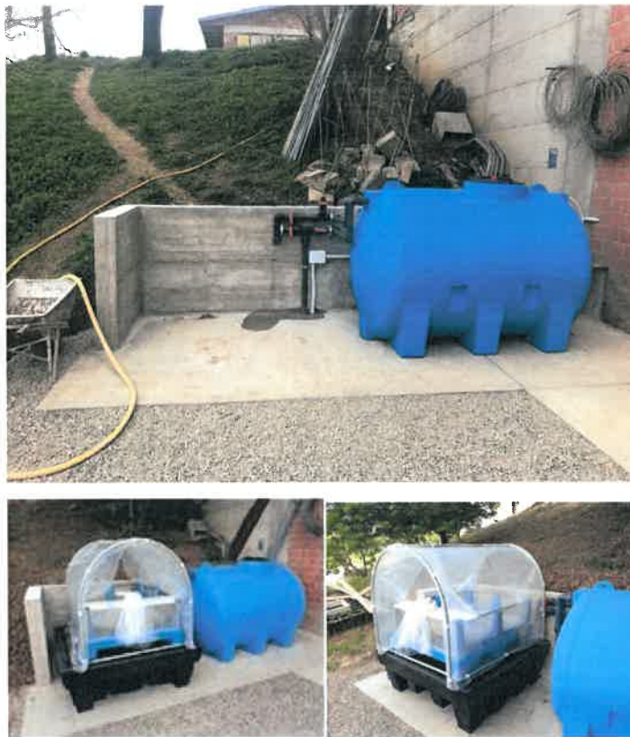
Figura 3.2.3. Osmofilm con tettuccio e cisterna raccolta acque
