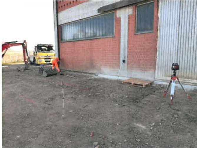
Figura 3.2.2. Lavori di predisposizione piazzola
