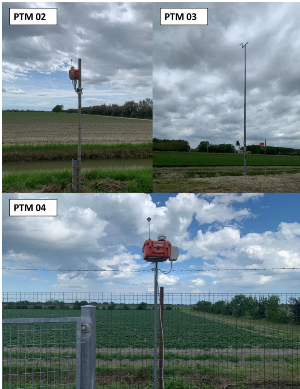
Figura 3. Le centraline installate nei rispettivi siti di monitoraggio
