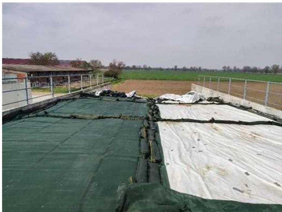
*Figure 6 - Effetto dell'impiego della rete di protezione anti-corvo. Nella parte destra (tesi tradizionale) è possibile vedere perforazioni sigillate in seguito mediante l'utilizzo di nastro*
