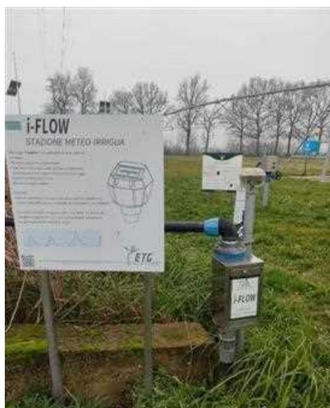
Figura 1 Idrante di consegna consortile presso Acqua Campus del CER
