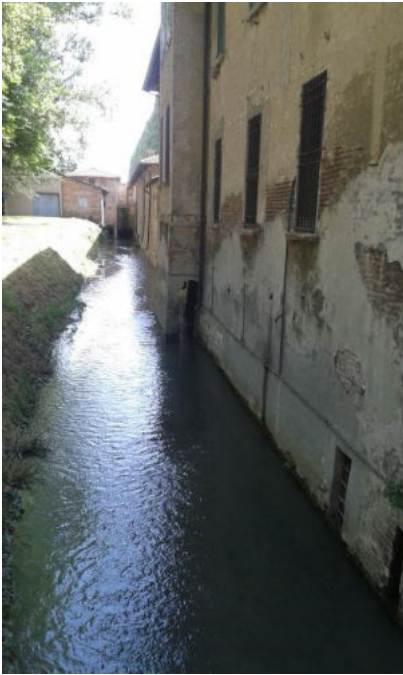
Figura 14: Il canal Torbido, nel tratto impermeabilizzato presso il castello.
