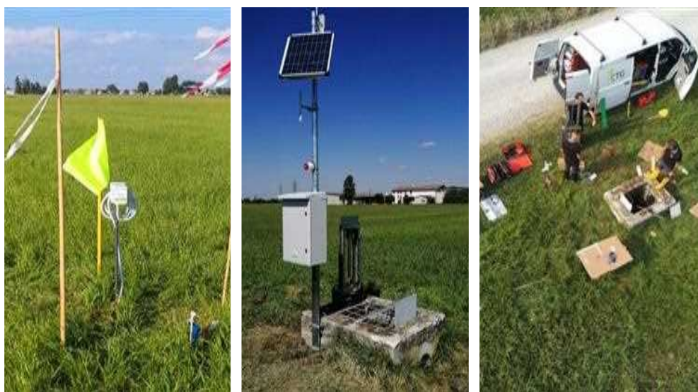
Figura 12: Installazione della paratoia 4.0
