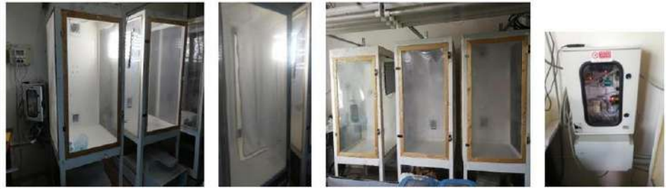
Figura 2 Unità collocate presso UCSC con micro PLC
