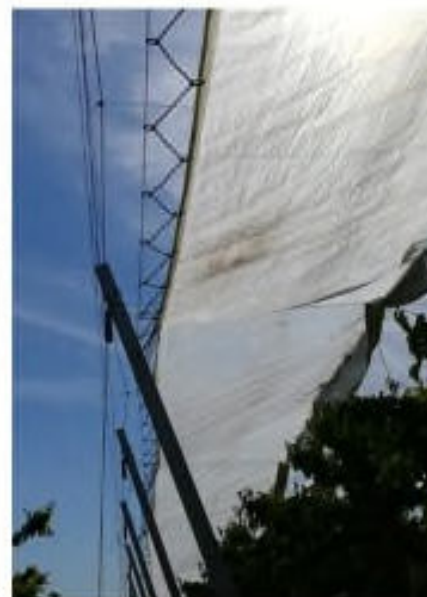
Particolari dei cavi di traino per l'apertura/chiusura dei teli
