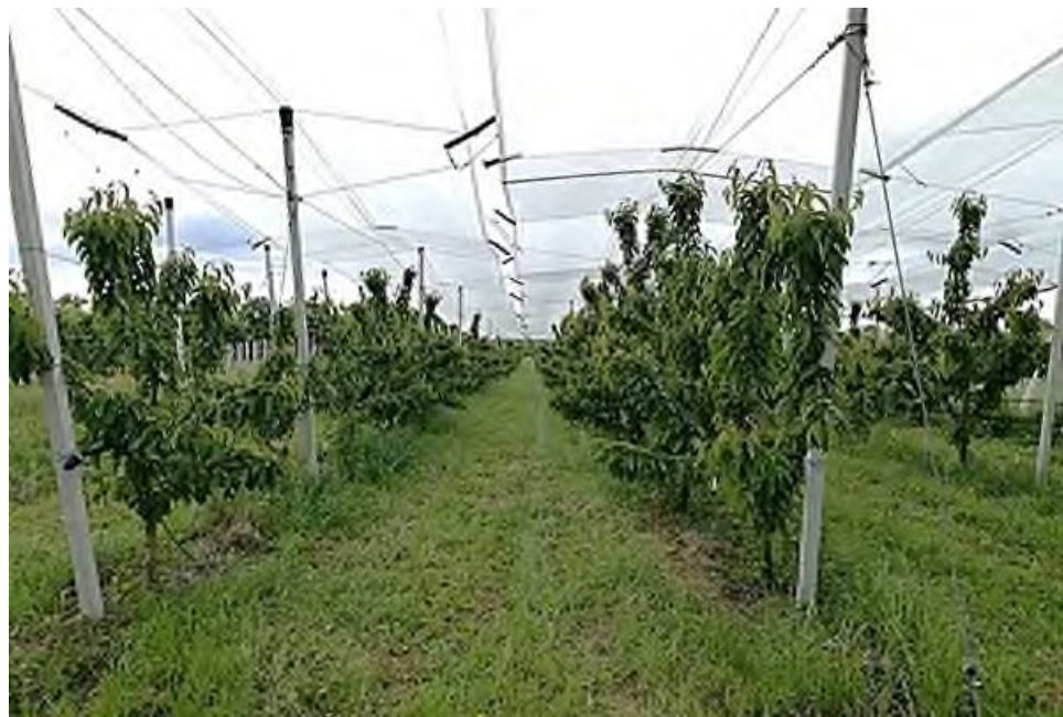
Sistema di copertura realizzato su impianto ex-novo
