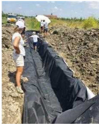
Figura 15 posa tessuto impermeabilizzato per copertura corpo del bioreattore
