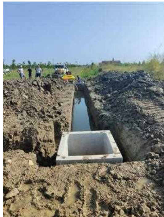
Figura 14 Scavo per la costituzione del bioreattore
