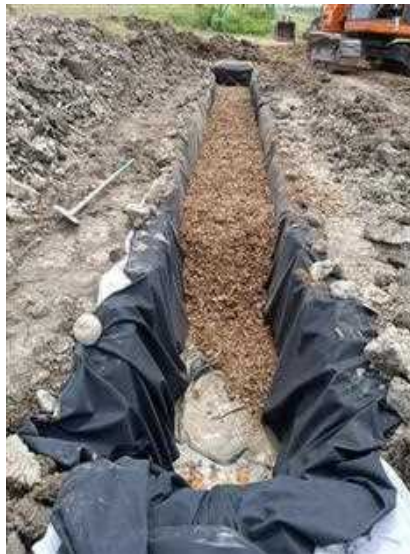
Figura 16 introduzione del materiale poroso costituente il corpo del bioreattore
