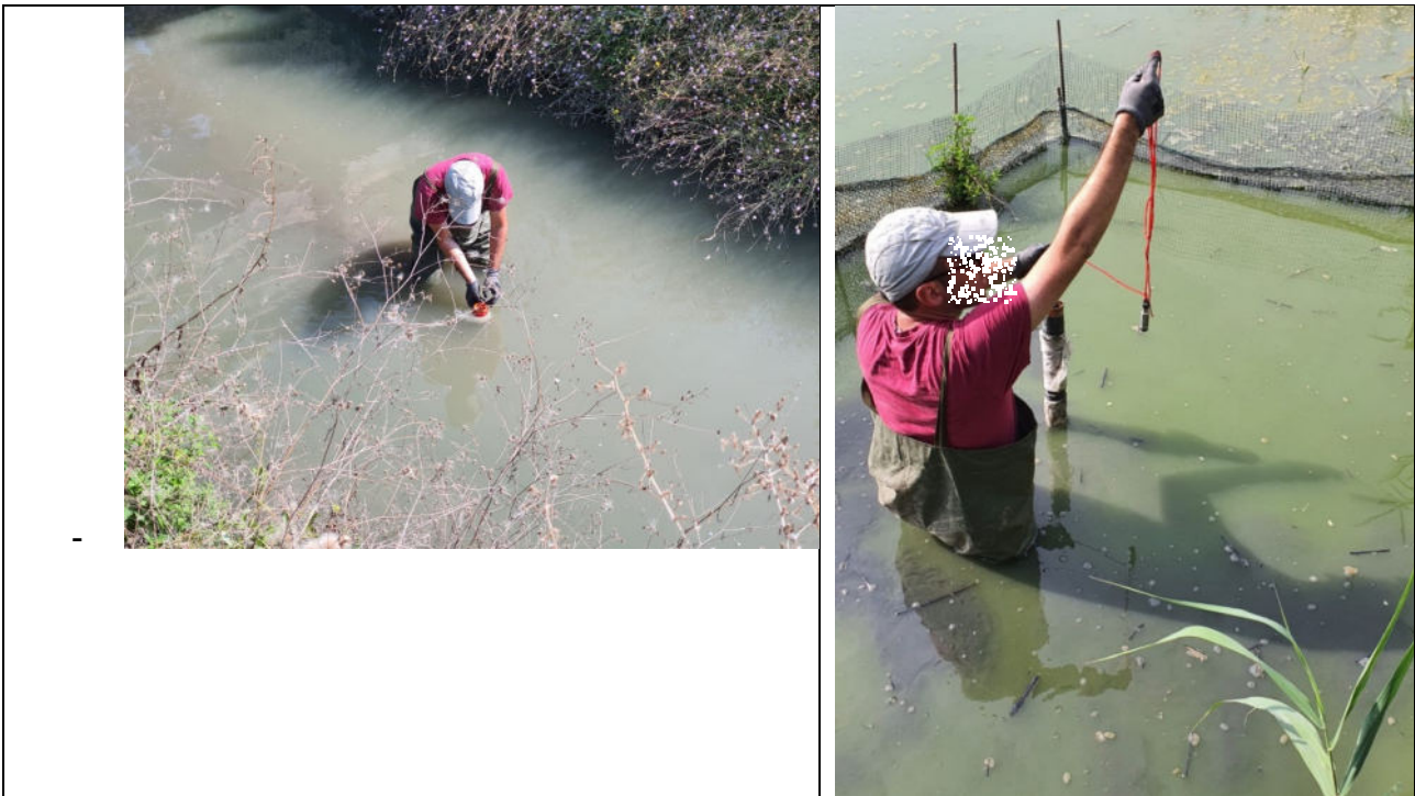
Figura 5: A sinistra: posa di un tubo di calma sul fondo del canale sul canale di San Giovanni; a destra: installazione di strumento di misurazione in continuo del livello dell'acqua nel punto di scarico dell'area fitodepurante.
