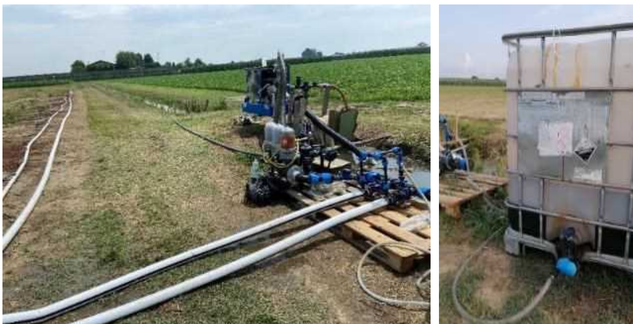
Figura 19. Motopompa e sistema di filtrazione ed iniezione del solfato ammonico in miscela all'acqua irrigua nelle ali gocciolanti (foto di sinistra) e soluzione di solfato ammonico di recupero impiegata come fertilizzante (foto di destra)
