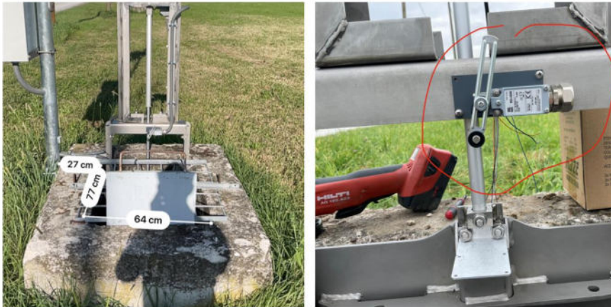
Figura 21: Paratoie installate per il prato stabile
