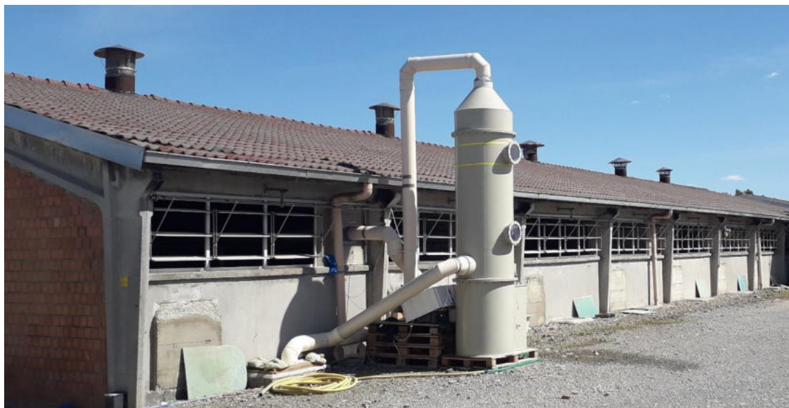
Figura 6 - Installazione del prototipo di trattamento presso l'allevamento Sant'Anna (2020)
