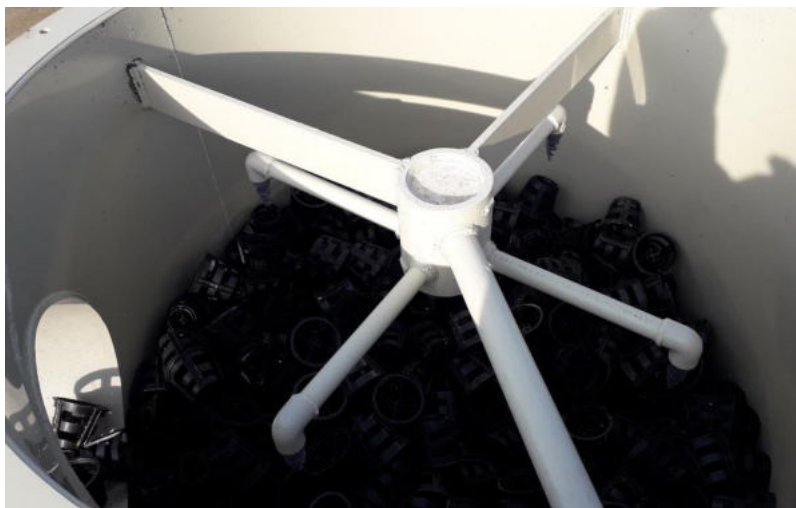
Figura 1 - Primo piano dell'interno della torre di lavaggio e dei corpi di riempimento utilizzati
