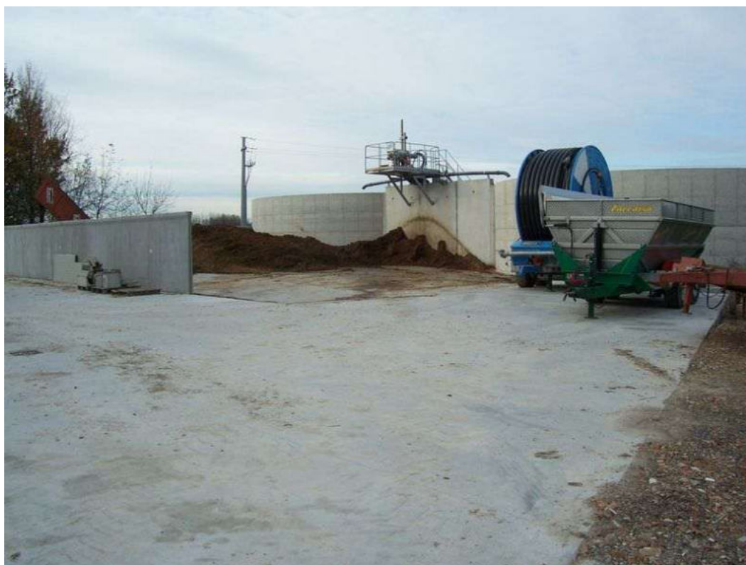
Figura 4.10 – Azienda B: concimaia con separatore e vasche per liquame
