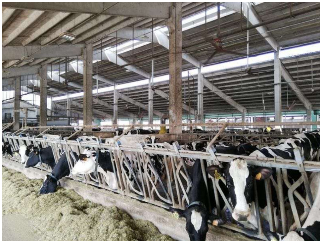
Figura 4.3 – Azienda A: ventilatori tipo elicottero
