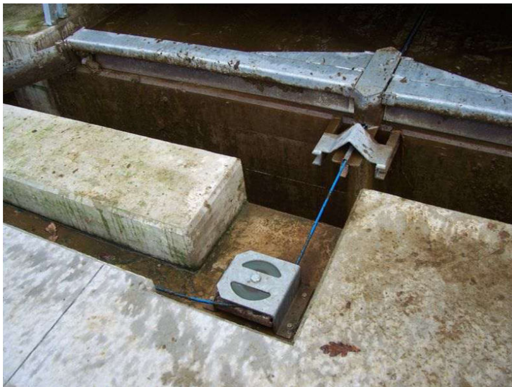
Figura 4.9 – Azienda B: raschiatore a fune
