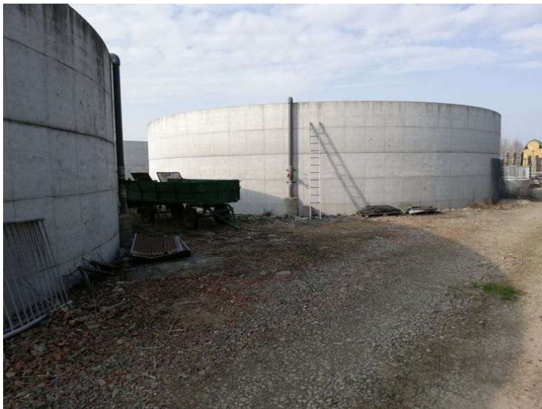
Figura 4.5 – Azienda A: vasche di stoccaggio degli effluenti
