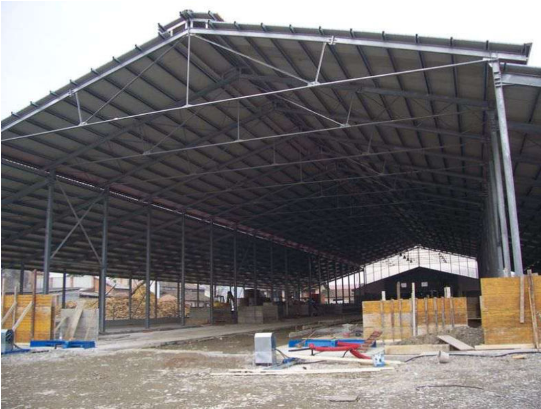
Figura 1.1 – Stalla per vacche da latte in costruzione, con tetto in pannelli sandwich
