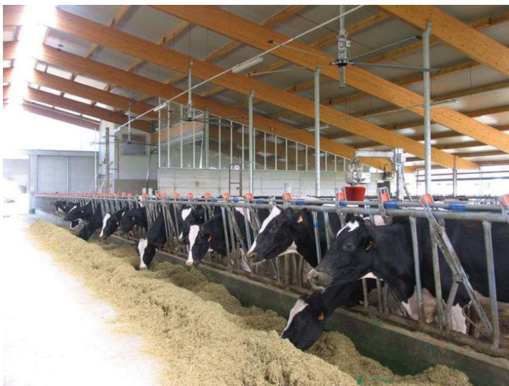
Figura 4.12 – Azienda C: ventilatori tipo elicottero
