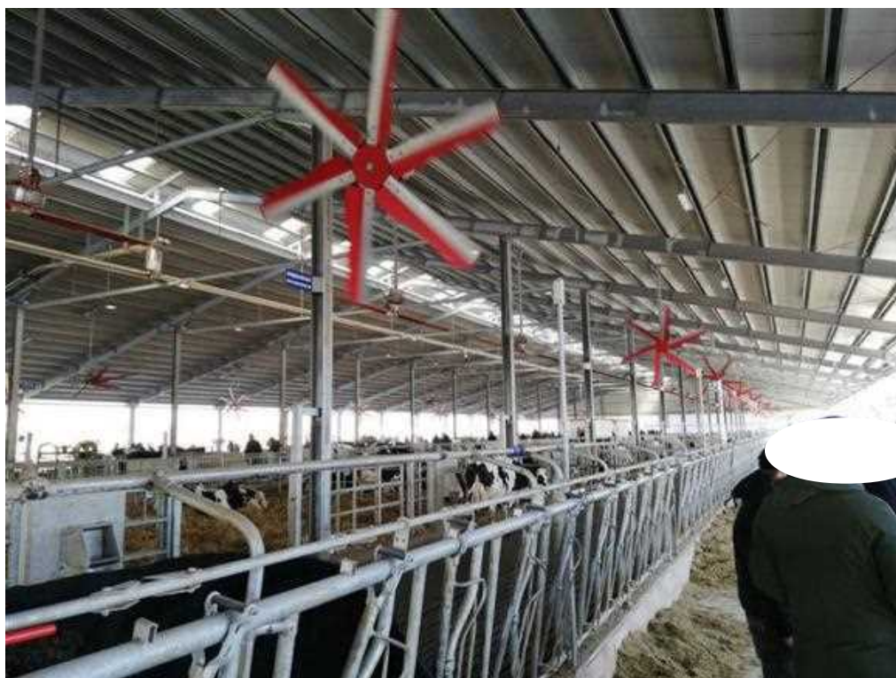
Figura 1.4 – Impianto di ventilazione di soccorso estivo
