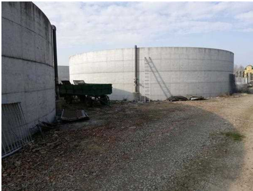
Figura 1.7 – Vasche di calcestruzzo armato per lo stoccaggio del liquame
