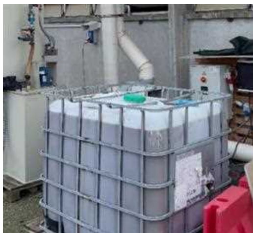
Figura 6.2.8 – Soluzione di solfato ammonico prodotta
