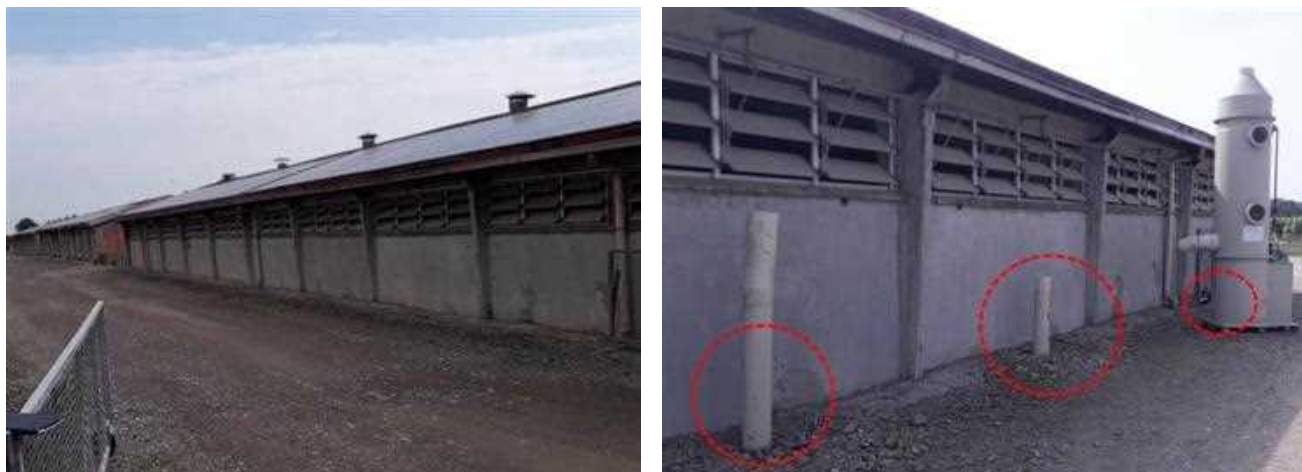
Figura 6.1.2 – Illustrazione delle attività di installazione dei condotti di aspirazione dell'aria da sotto fessurato con perforazione della parete laterale dell'edificio.
