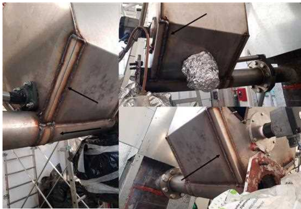
Fig.11: Rinforzi applicati al telaio della tramoggia.
